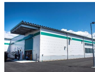
青森五所川原工場増築 (2021年4月)
