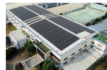
リズム協伸ベトナムの太陽光パネル
