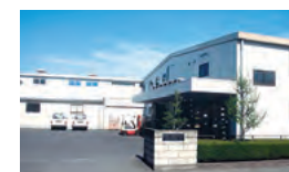
宇都宮工場 Utsunomiya Factory
